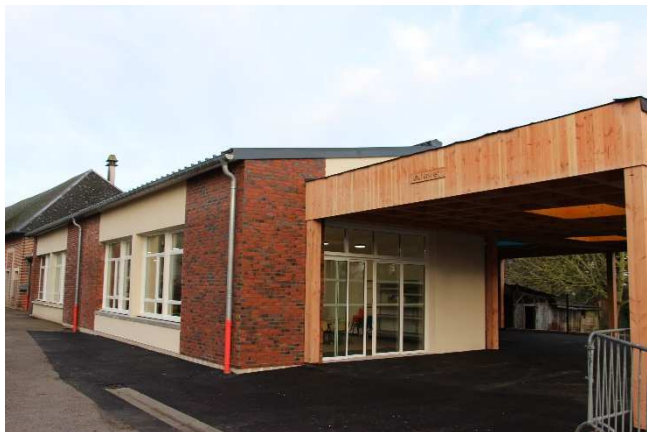
Extension rénovation de la cantine scolaire avec un self pour les élèves de primaire
