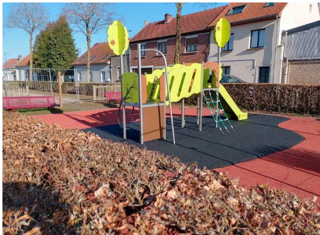
Installation d'un nouveau jeu rue de Daours
